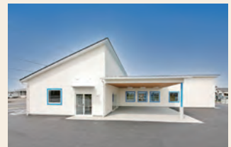
完成商業施設
